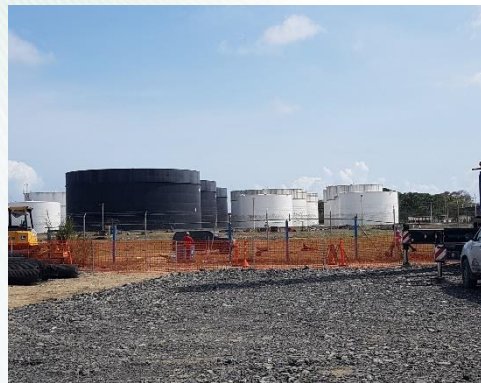
Tanques de Almacenamiento
