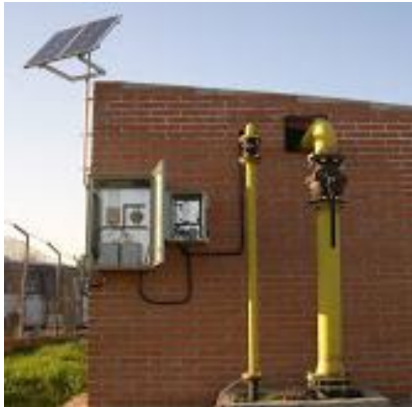
Telecontador alimentado por energía solar
