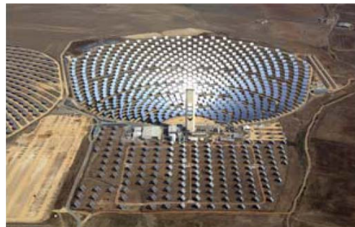
PS 10, 11MW, Sevilla, Espanha.
