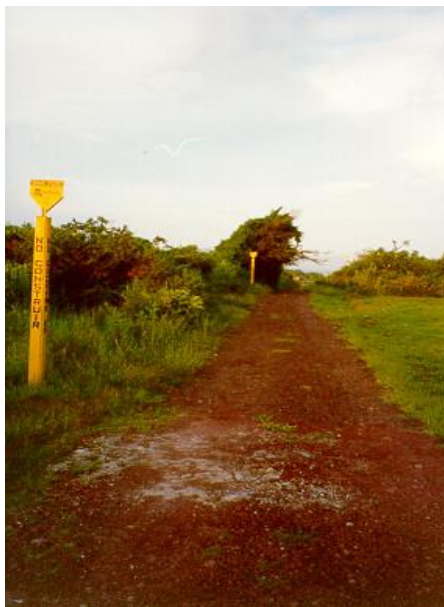
Señalamientos y franja de afectación
