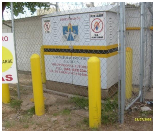
Puntos de entrega (Estaciones de Regulación y medición)
