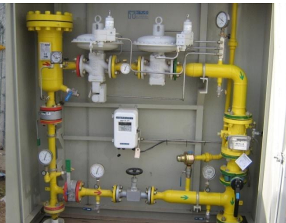
Puntos de entrega (Estaciones de Regulación y medición)
