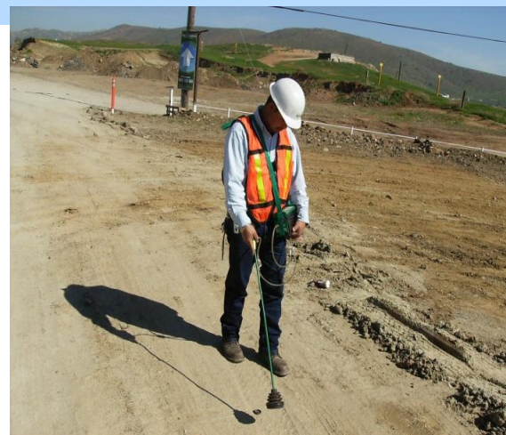
Inspección de fugas
