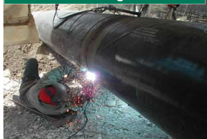
Soldadura del gasoducto
