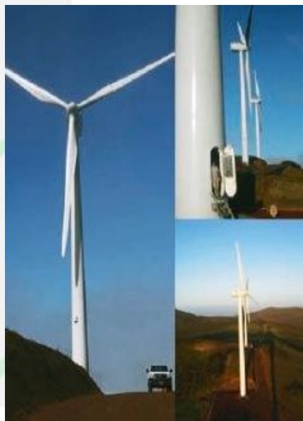
Parque eólico. Islas Galápagos
