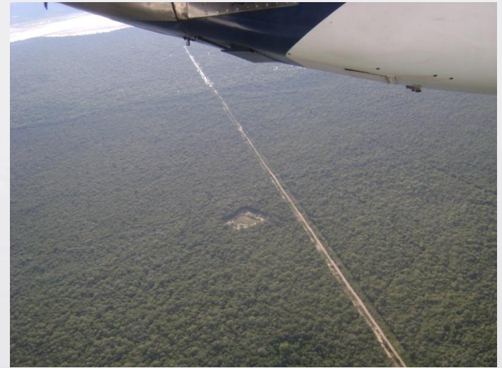
Vista Aérea DDV GTB
