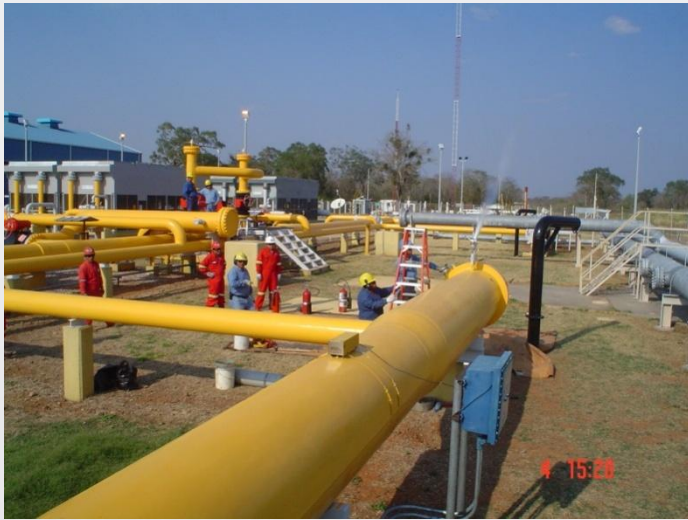
Limpieza (Chanqueo Gasoducto)
