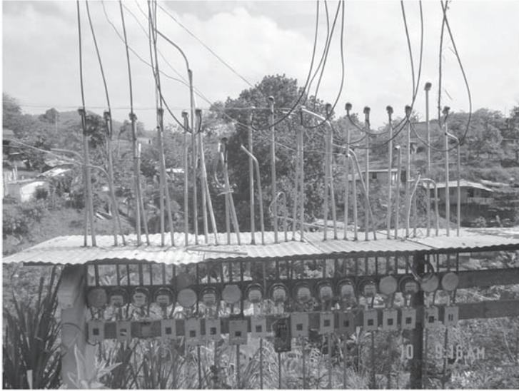
FIGURA 7. *Alambrado después del medidor sin cumplir medidas de seguridad*
